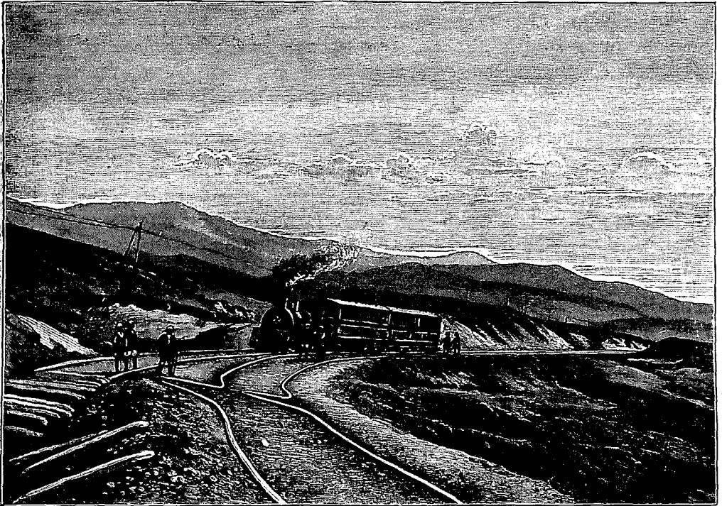
Фиг. 138. Рельсы, передвинутые горизонтальнымъ движеніемъ почвы при землетрясеніи у Саицала въ 1892 г. (Гризебахъ).
